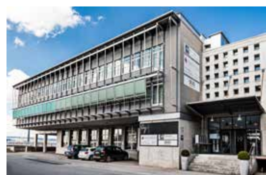
Einen Steinwurf von der Hauptstadt entfernt: Standort Ittigen BE.
